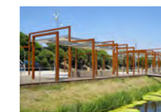
PARC CORREDERA Martirià Figueras (ESPANHA, 2010)
